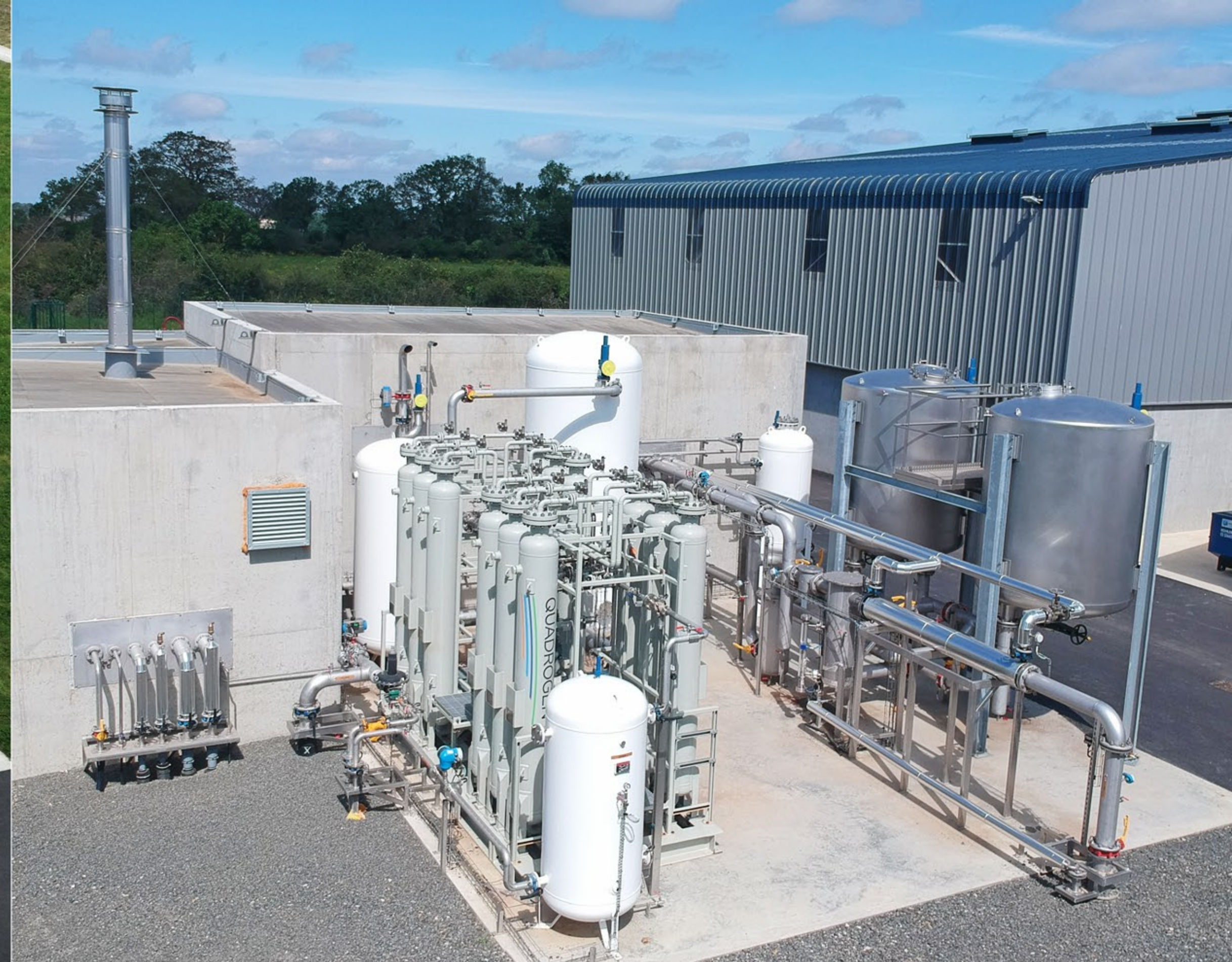
Filtration, Compression et Epuration du Biogaz de méthanisation agricole Compression du Biogaz à 14 barg pour injection dans le réseau GRDF MPB PSA rotatif de 500 Nm 3 /h de biogaz, 250 Nm 3 /h de biométhane Valorisation thermique du gaz pauvre; Contrat de maintenance et supervision sur 15 ans
