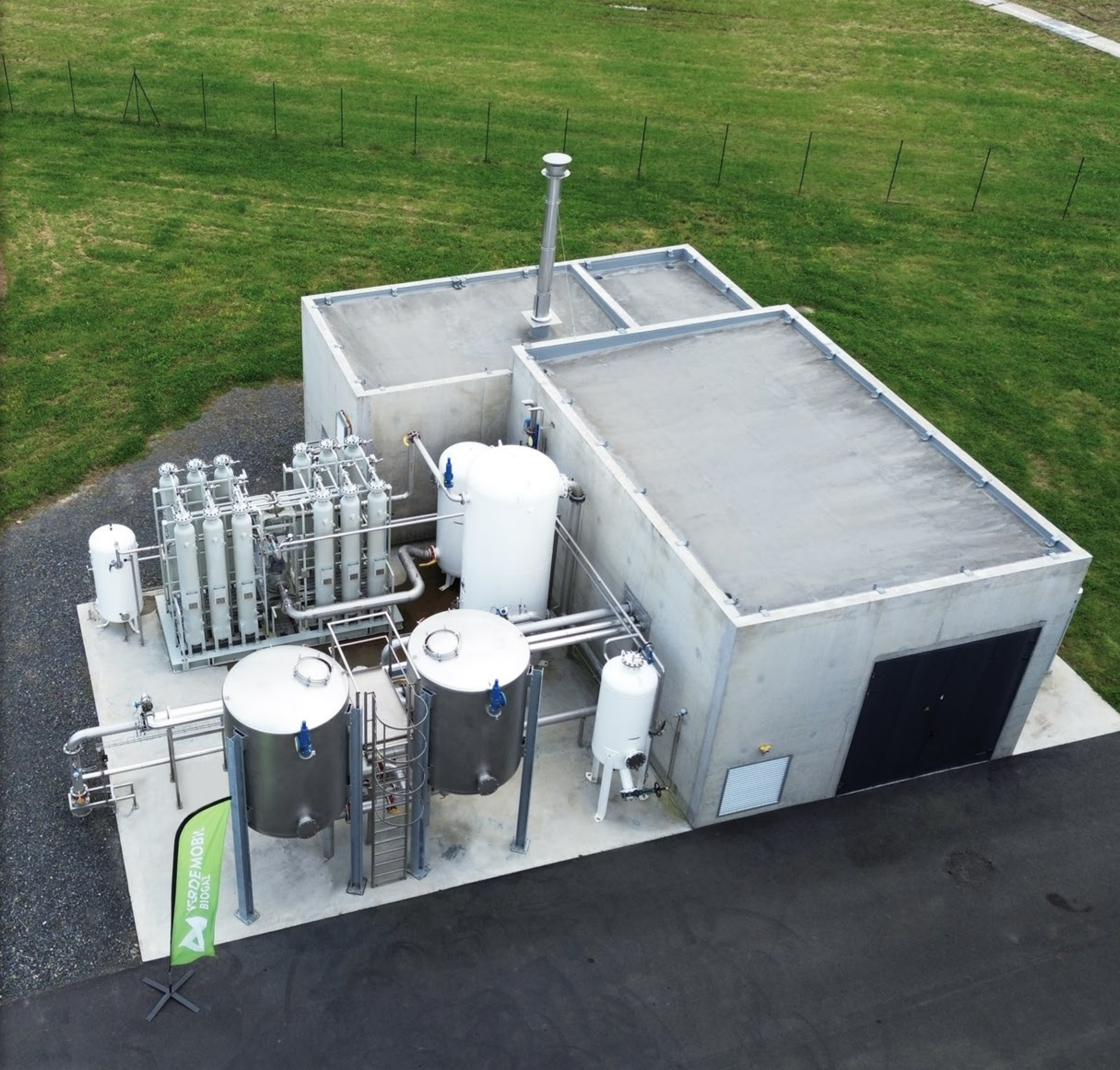
Filtration, Compression et Epuration du Biogaz de méthanisation agricole Compression du Biogaz à 14 barg pour injection dans le réseau GRDF MPB PSA rotatif de 500 Nm 3 /h de biogaz, 250 Nm 3 /h de biométhane Valorisation thermique du gaz pauvre; Contrat de maintenance et supervision sur 15 ans
