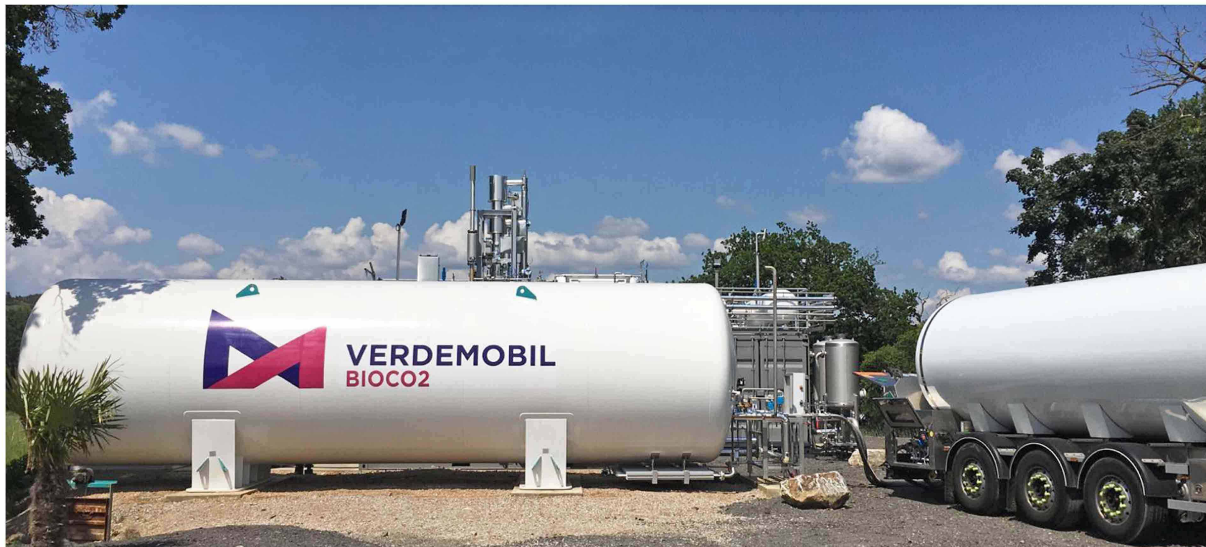
Recyclage du gaz pauvre, Compression, Purification. Conception et réalisation de la production de BioCO 2 . Liquéfaction Cryogénique du BioCO 2 . Production de 4340 Tonnes/ an de BioCO 2 . Contrat de maintenance et supervision sur 15 ans.
